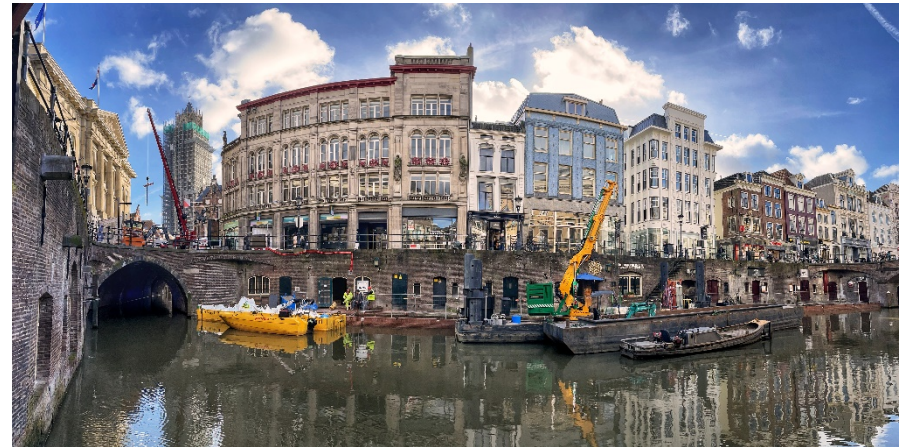
Combinatie van werkzaamheden: gemeente Utrecht herstelt walmuren, Magazijn De Zon en de werfkelders. Eneco vervangt de warmteleiding
