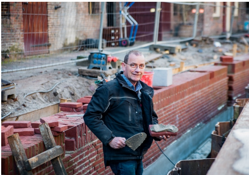
Werk aan de walmuren Oudegracht
