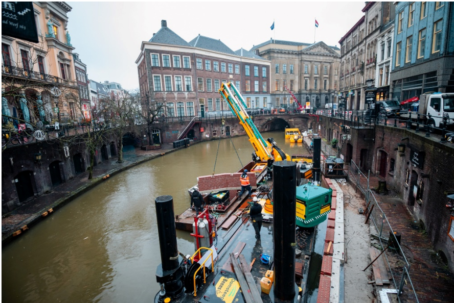
Herstel walmuur bij Stadhuisbrug
