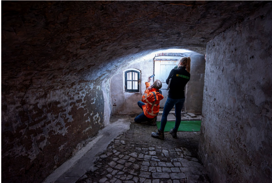
Inspectie in een werfkelder
