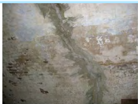
Foto 5: Gerepareerde scheur dwars over de hele kelder
