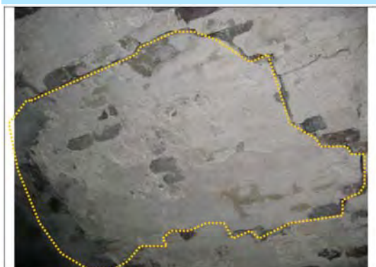
Foto 7A: getekend: een losse metselwerkschijf in gewelf
