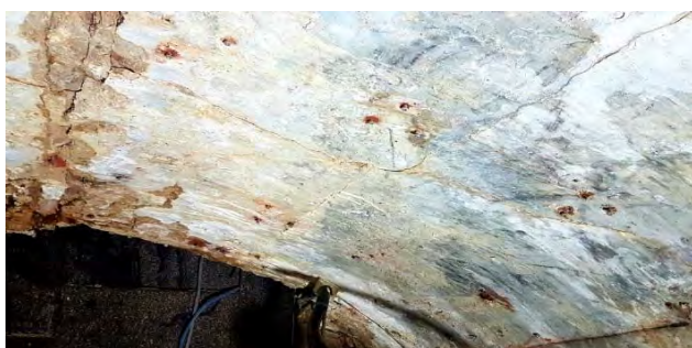
Figuur 5: Voorbeeld van scheurvorming, (bron: Presentatie expertmeeting op 16-10-2020 door de gemeente Utrecht).
