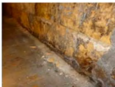
Figuur 10: Uitbloei metselwerk.
