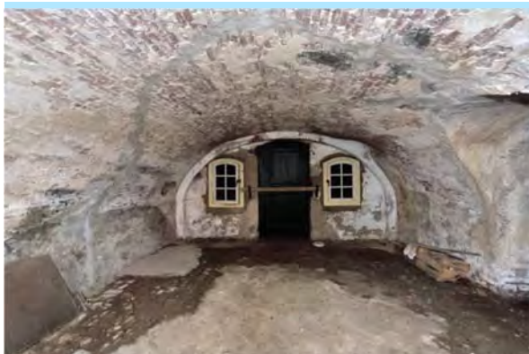
Deur en ramen aan de grachtzijde. Scheur AB in metselwerk.
