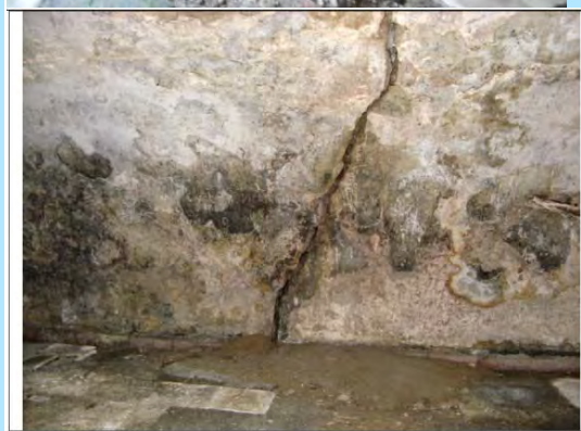
Foto 7: Scheurwijde plaatselijk ca. 30mm, uitgespoeld zand
