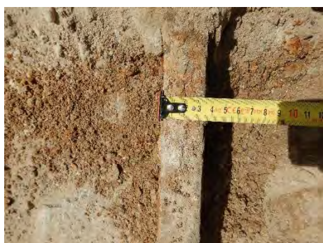
Figuur 12: Foto van licht/oppervlakkig gecorrodeerde ankerstang.
