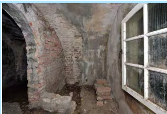
Raam aan de grachtzijde, met scheur AC in metselwerk.
