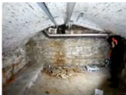
Figuur 8: Witte uitslag door zouten.
