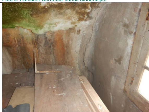
Foto 4: Scheur tegen werfmuur noordzijde
