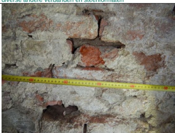
Foto 12: kelder 2 afmetingen metselstenen +/- l= 15 cm, h= 6 cm. Dit deel van de kelder = Kruisverband, afgewisseld met diverse andere verbanden en steenformaten
