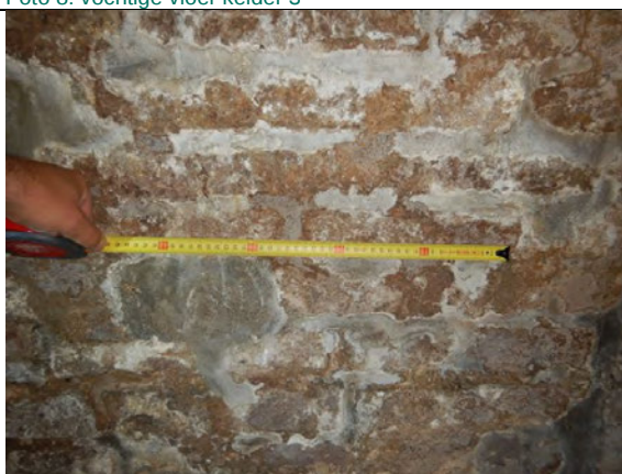
Foto 10: kelder 3 afmetingen metselstenen +/- l= 25 cm, h= 5 cm Dit deel van de kelder = Klezorenverband, afgewisseld met diverse andere verbanden en steenformaten
