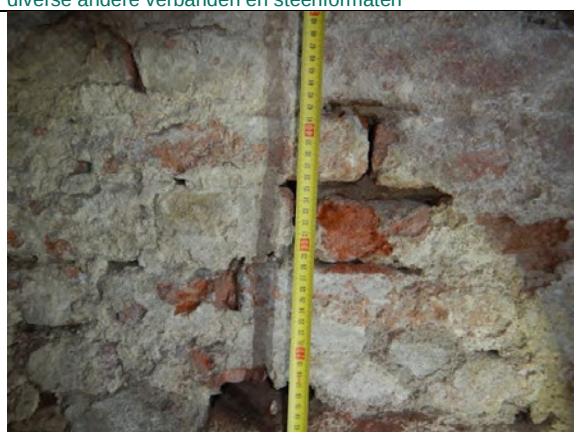
Foto 11: kelder 2 afmetingen metselstenen +/- l= 15 cm, h= 6 cm. Dit deel van de kelder = Kruisverband, afgewisseld met diverse andere verbanden en steenformaten
