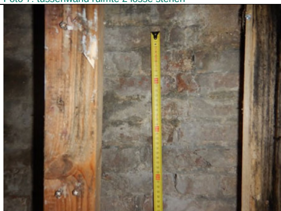
Foto 9: ruimte 1 afmetingen metselstenen +/- l= 22 cm, h= 4 cm wildverband
