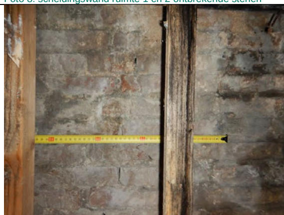
Foto 10: ruimte 1 afmetingen metselstenen +/- l= 22 cm, h= 4 cm wildverband
