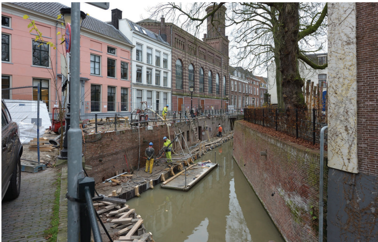
Afb. 6.1 – Werkzaamheden rak 21, december 2017
