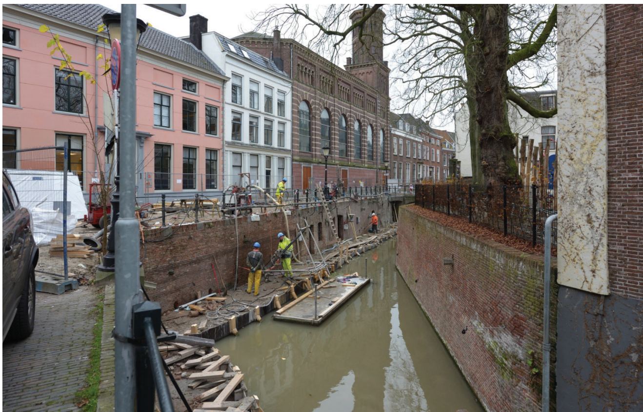
Afb. 6.1 – Werkzaamheden rak 21, december 2017
