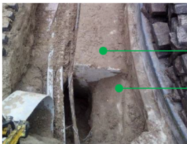
Foto nr. 2 aansluiting brug betonfundatie
