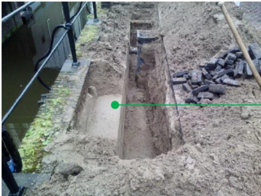
Foto nr. 8 betonfundatie proefsleuf huisnummer
