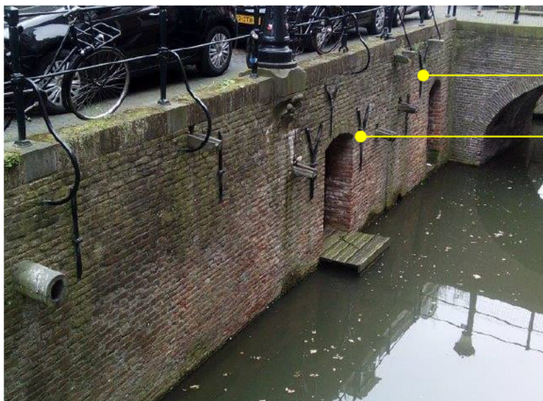
Foto nr. 15 Gevel ankers 2 niveaus
