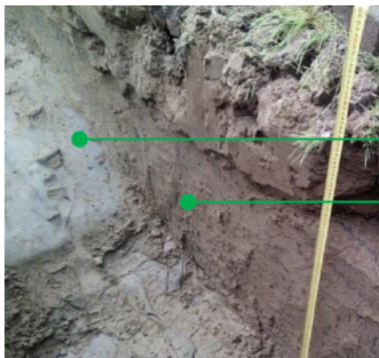
Foto nr. 3 aansluiting brug betonfundatie
