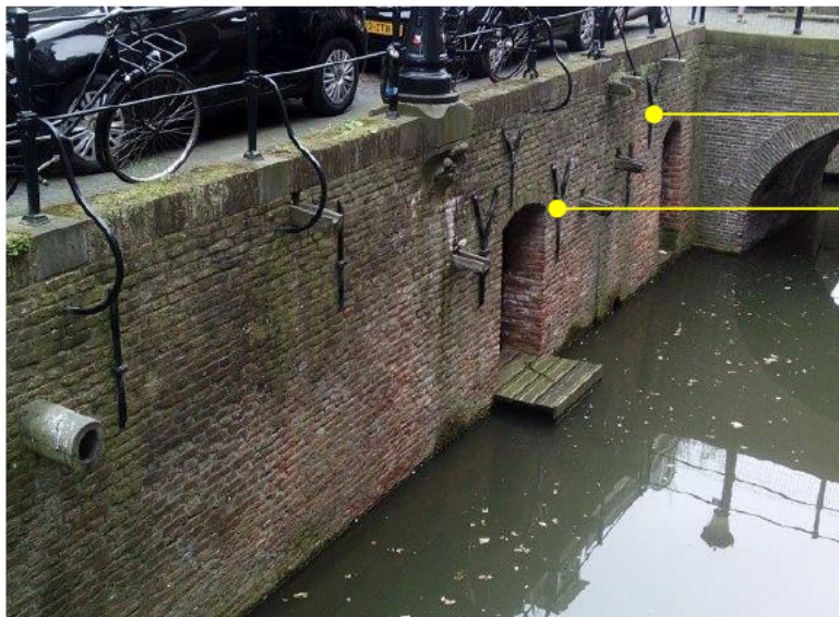
Foto nr. 15 Gevel ankers 2 niveaus
