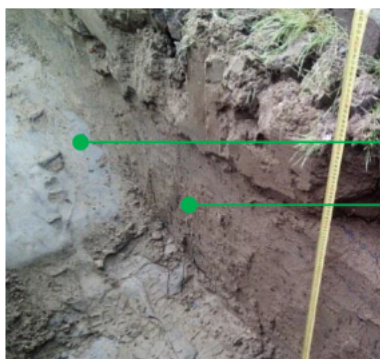
Foto nr. 3 aansluiting brug betonfundatie
