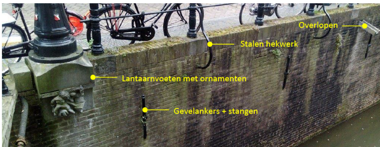
Foto nr. 1 kademuur
