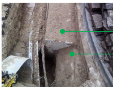
Foto nr. 2 aansluiting brug betonfundatie
