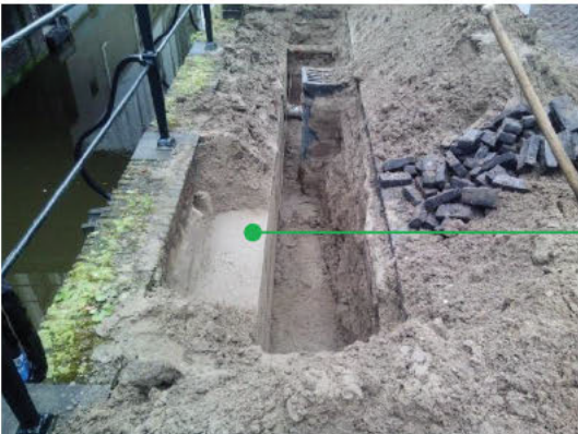
Foto nr. 8 betonfundatie proefsleuf huisnummer
