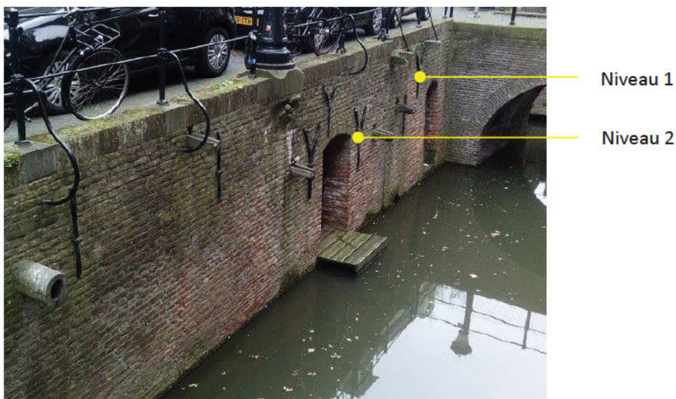
Foto nr. 15 Gevel ankers 2 niveaus
