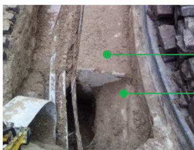
Foto nr. 2 aansluiting brug betonfundatie
