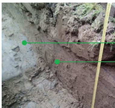
Foto nr. 3 aansluiting brug betonfundatie
