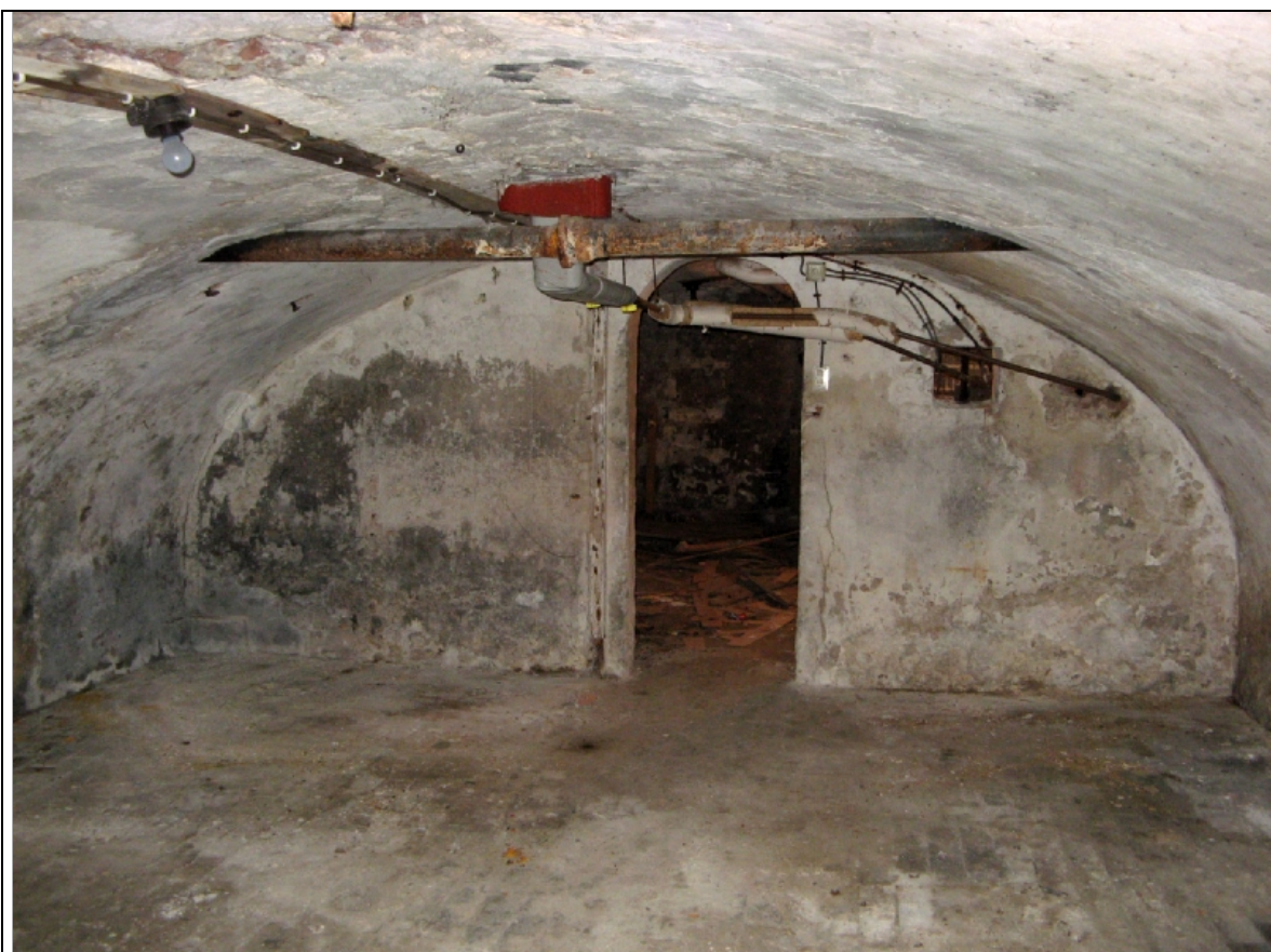
Foto 2: Doorzicht werfkelder (gezien vanaf waterzijde)
