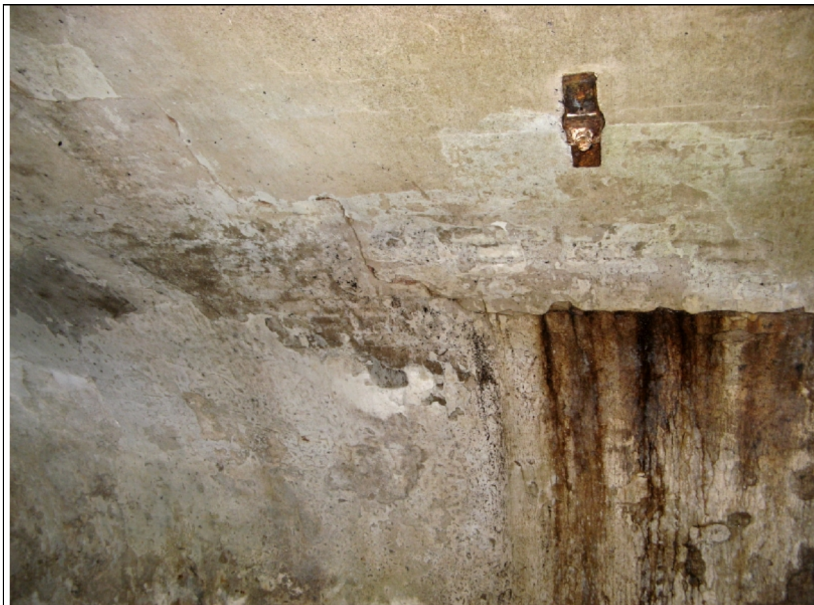
Foto 7: Doorgaande scheuren over gewelf en wanden.
