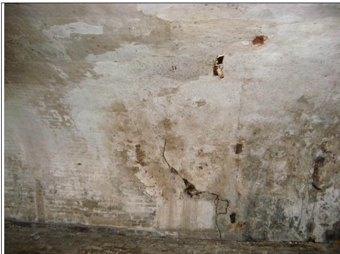
Foto 8: Doorgaande scheuren over gewelf en wanden.
