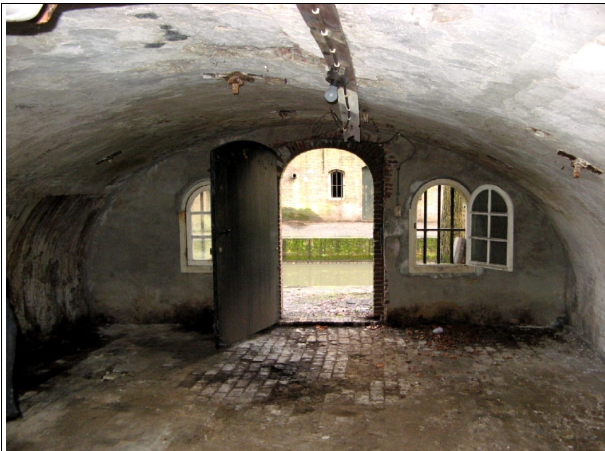
Foto 3: Aanzicht binnenzijde werfmuur.
