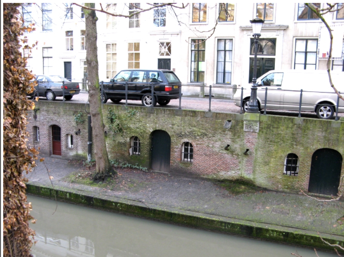
Foto 1: Aanzicht werfkelder buitenzijde
