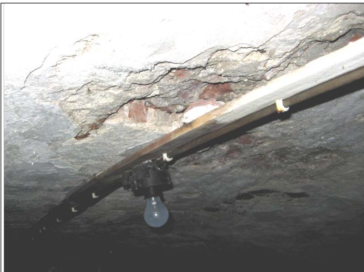
Foto 6: Doorgaande scheuren over gewelf en wanden.
