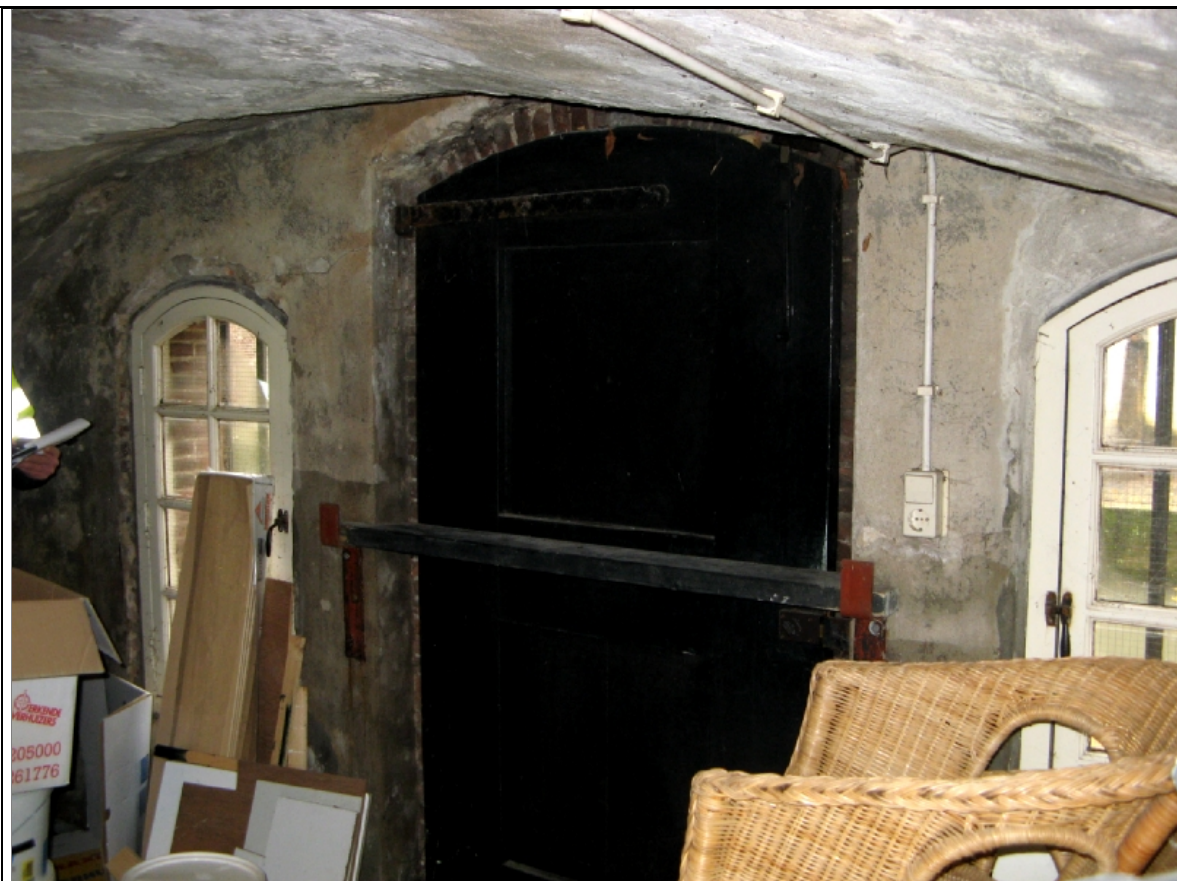
Foto 3: Aanzicht werfmuur binnenzijde.
