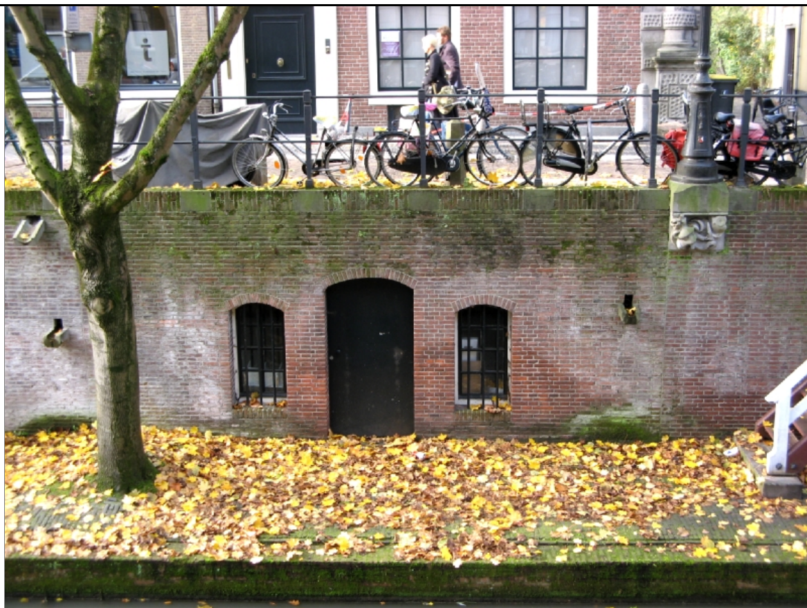
Foto 1: Aanzicht werfkelder buitenzijde
