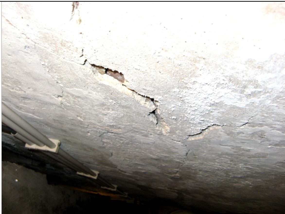
Foto 7: Langsscheur in gewelf.
