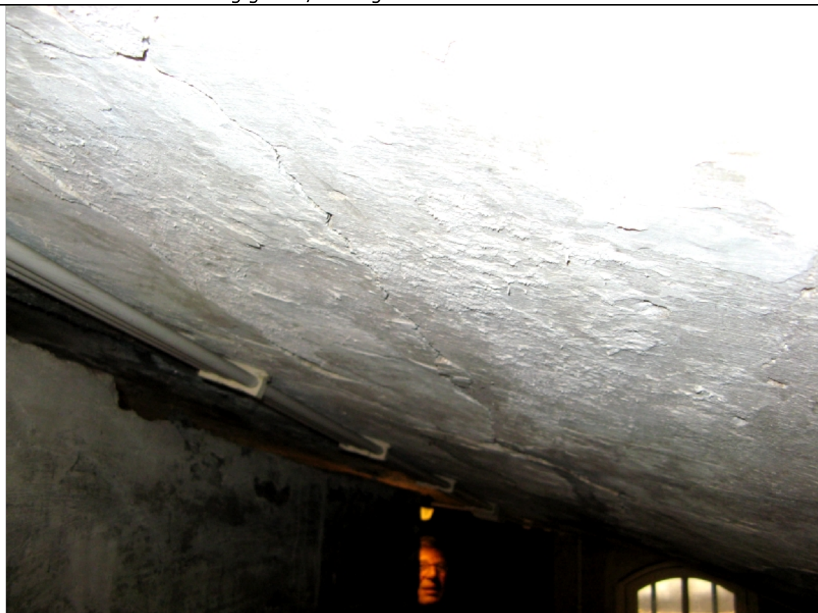
Foto 6: Langsscheur in gewelf.
