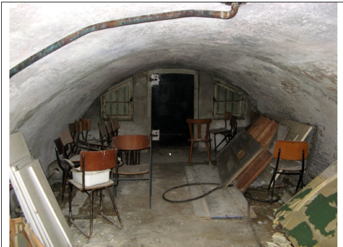
Foto 3: Aanzicht binnenzijde werfmuur
