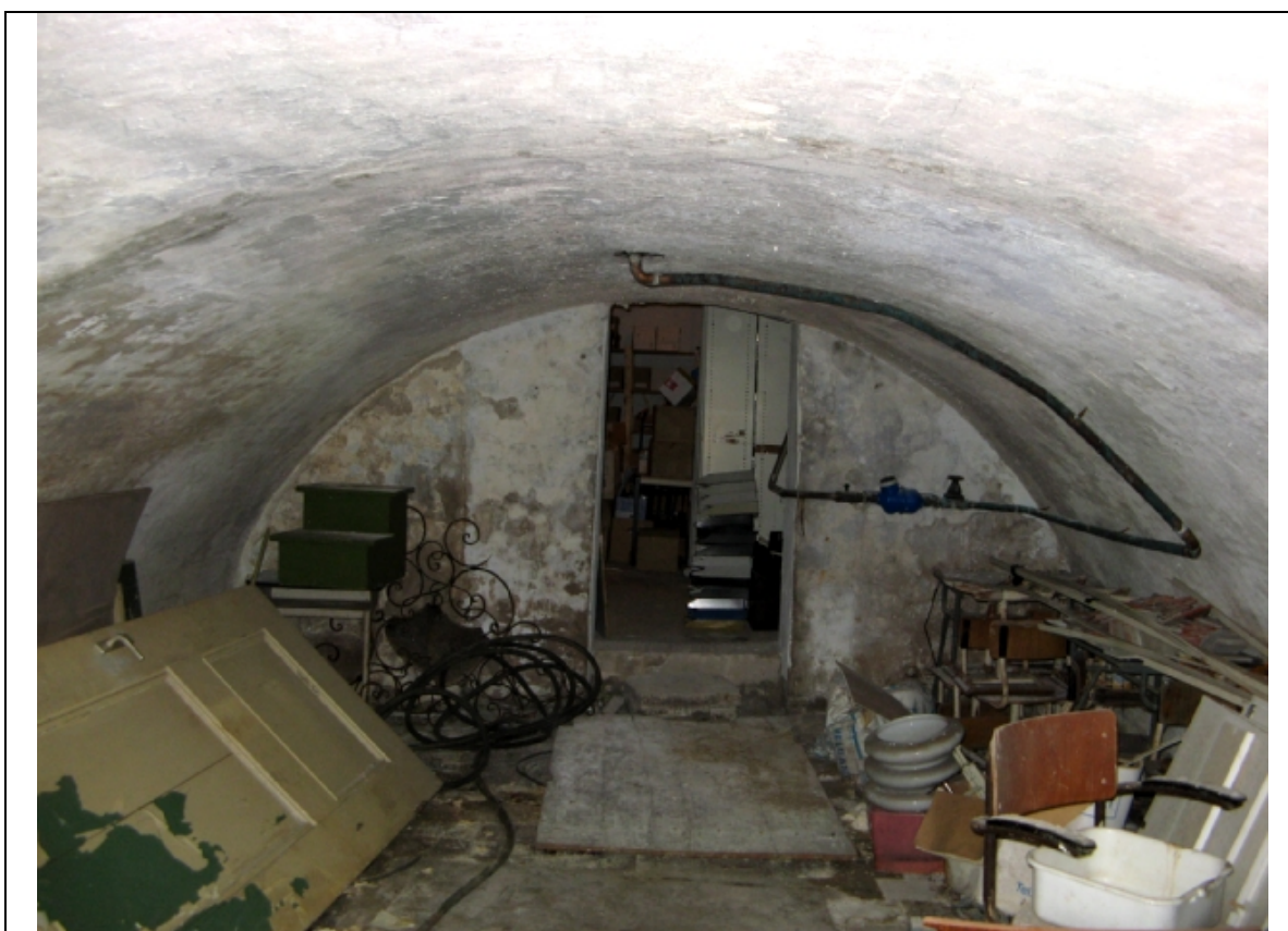
Foto 2: Doorzicht werfkelder (gezien vanaf waterzijde)
