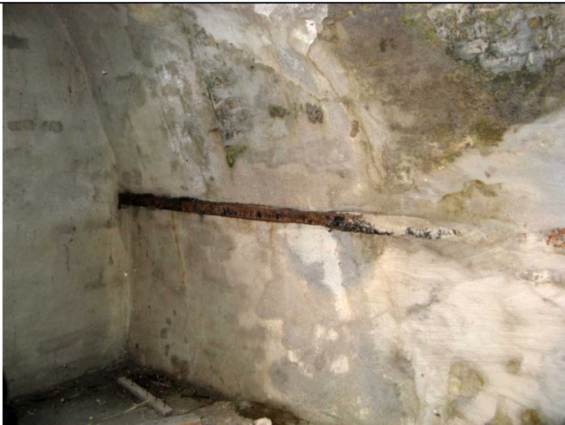
Foto 5: Muuranker verroest
