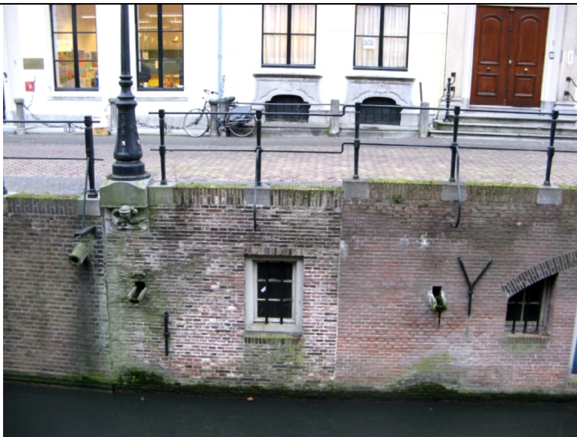
Foto 1: Aanzicht werfkelder buitenzijde
