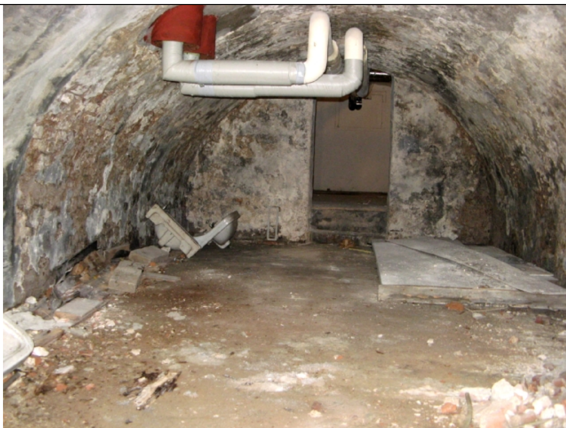
Foto 2: Doorzicht werfkelder (gezien vanaf waterzijde)
