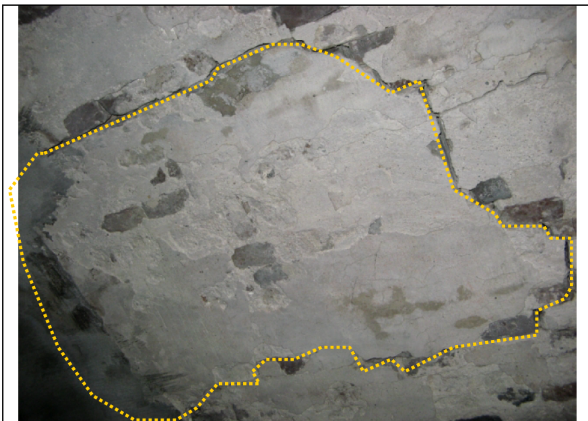
Foto 7A: getekend: een losse metselwerkschijf in gewelf
