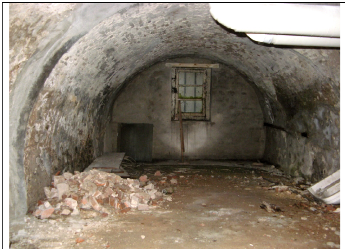
Foto 3: Aanzicht binnenzijde werfmuur
