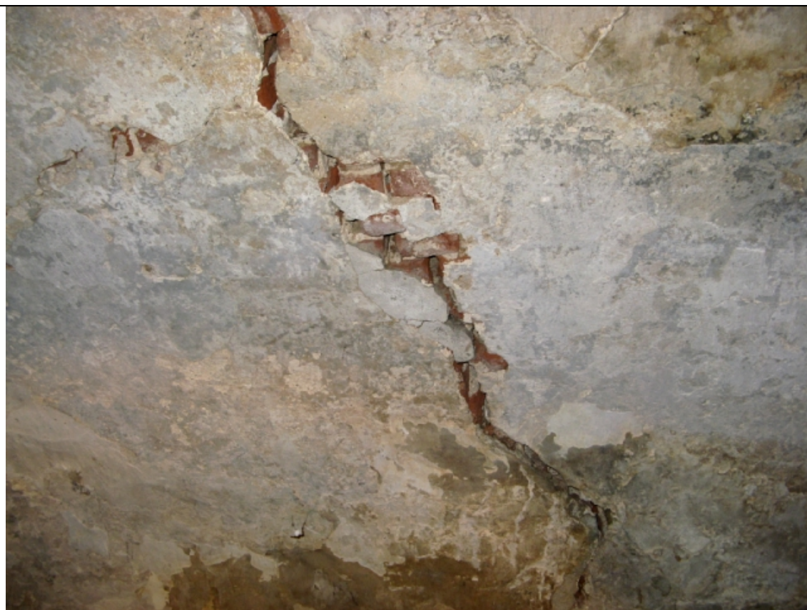
Foto 8: Scheur loopt door in gewelf, scheurranden verschoven t.o.v. elkaar
