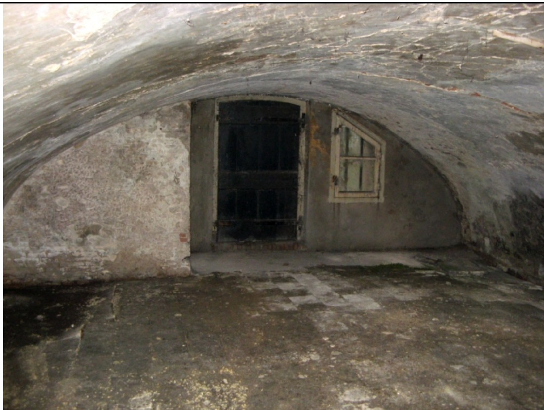
Foto 3: Aanzicht binnenzijde werfmuur
