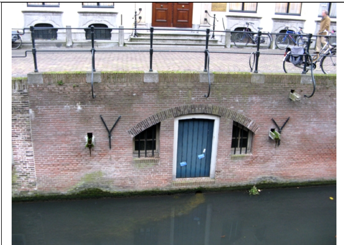
Foto 1: Aanzicht werfkelder buitenzijde
