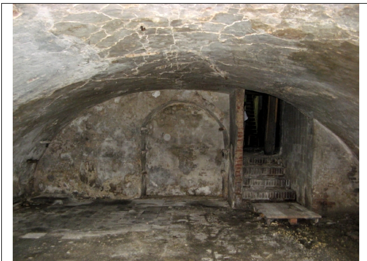
Foto 2: Doorzicht werfkelder (gezien vanaf waterzijde)
