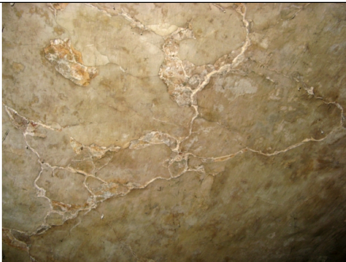
Foto 9: Diverse lichte scheuren in gewelf
