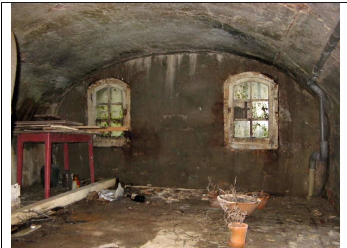
Foto 3: Aanzicht binnenzijde werfmuur
