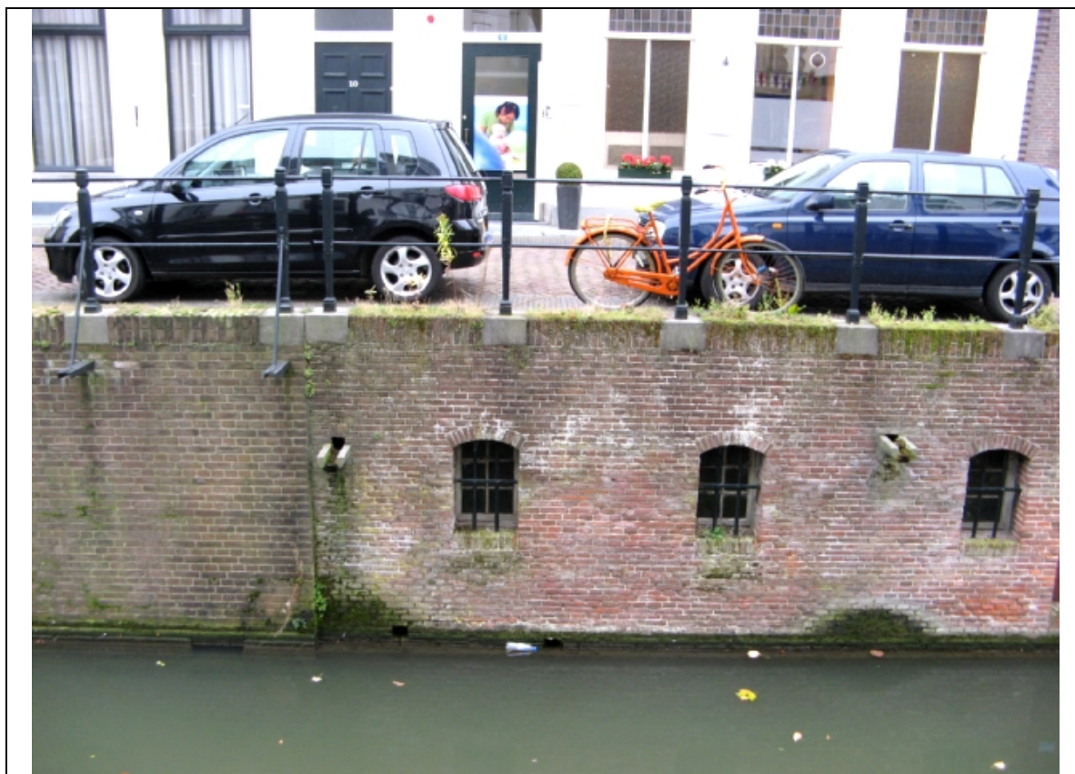
Foto 1: Aanzicht werfkelder buitenzijde
