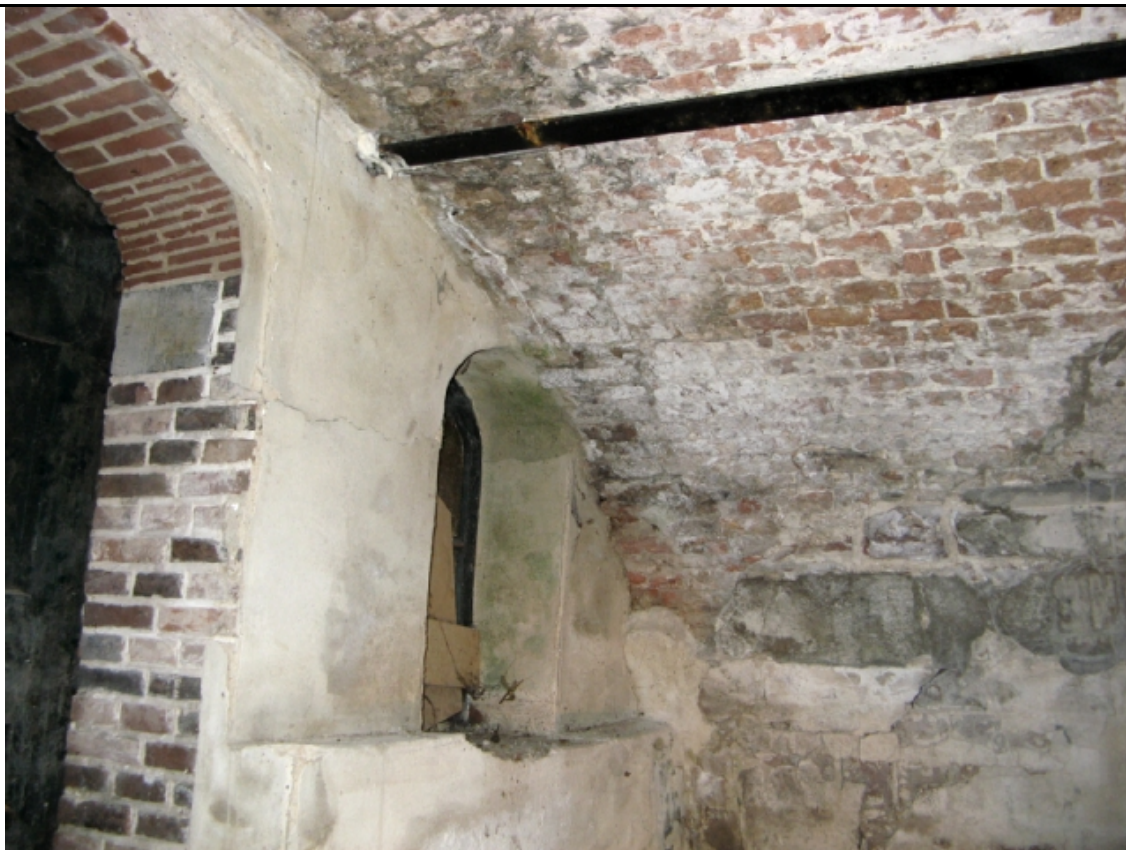
Foto 5: Diverse scheuren in gewelf en werfmuur
