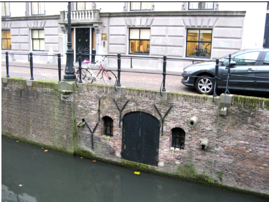
Foto 1: Aanzicht werfkelder buitenzijde
