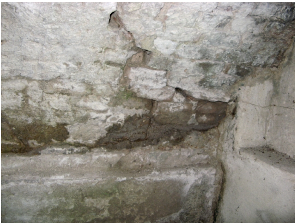
Foto 6: Scheur in overgangsgebied gewelf/ linker wand
