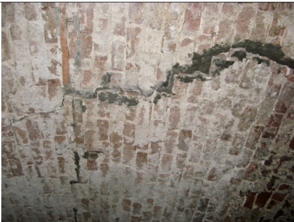
Foto 10: Dwarsscheur in gewelf
