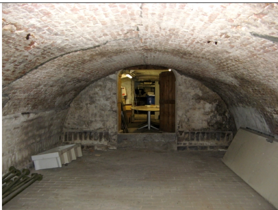
Foto 2: Doorzicht werfkelder (gezien vanaf waterzijde)
