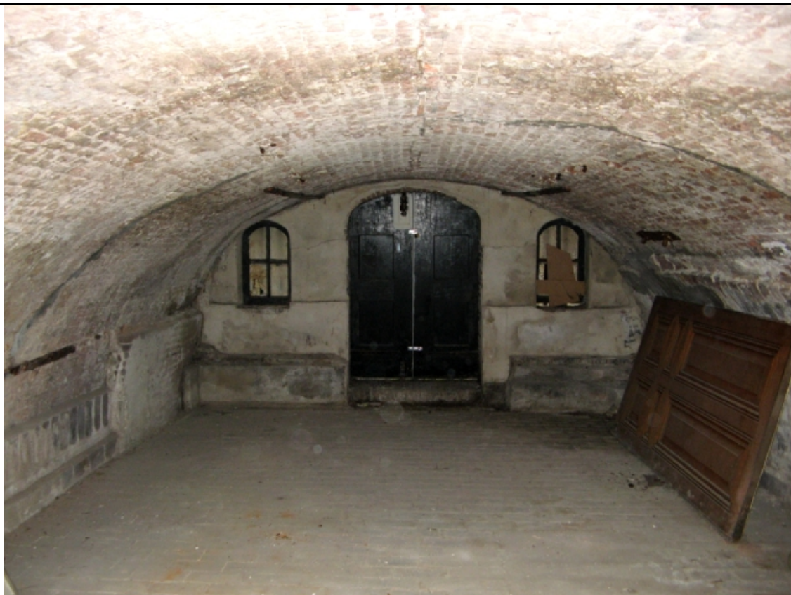
Foto 3: Aanzicht binnenzijde werfmuur
