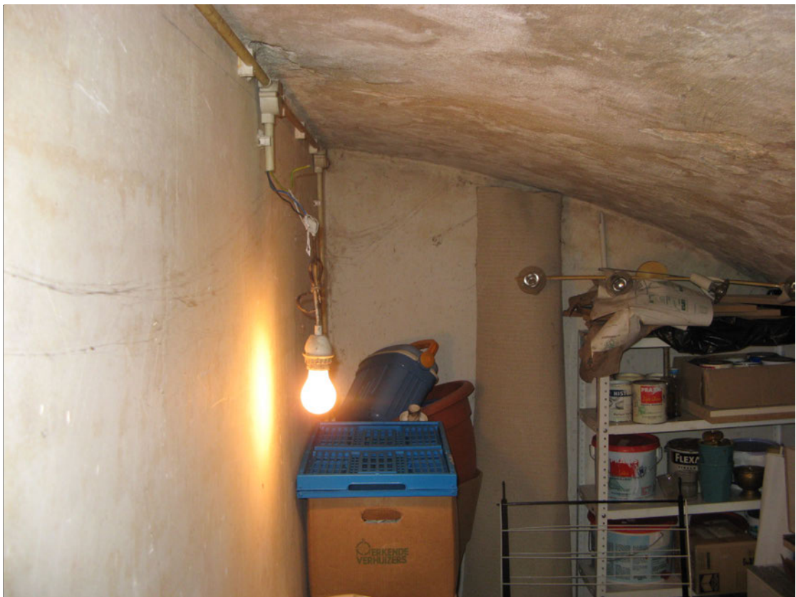
Foto 2: Doorzicht werfkelder (gezien vanaf waterzijde)
