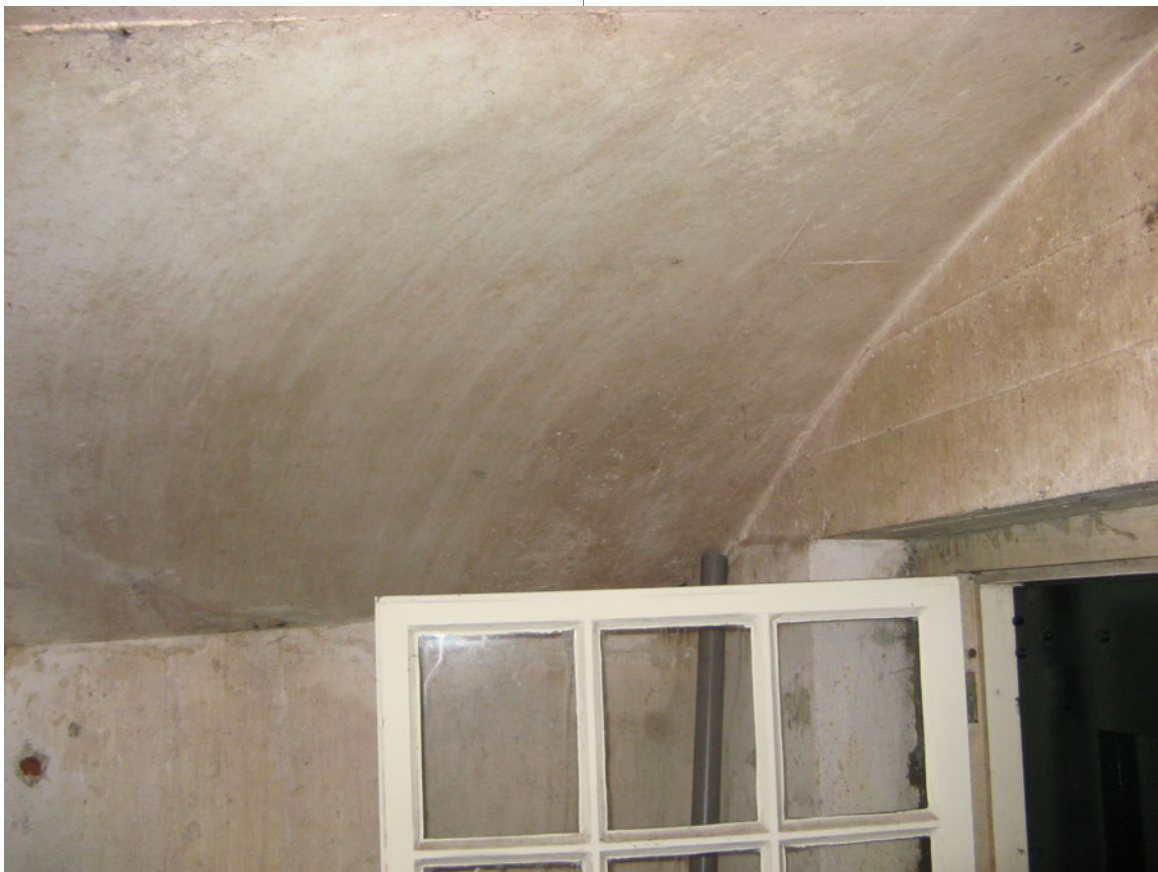
Foto 3: Betonconstructie gewelf/wand binnen 1 m.
