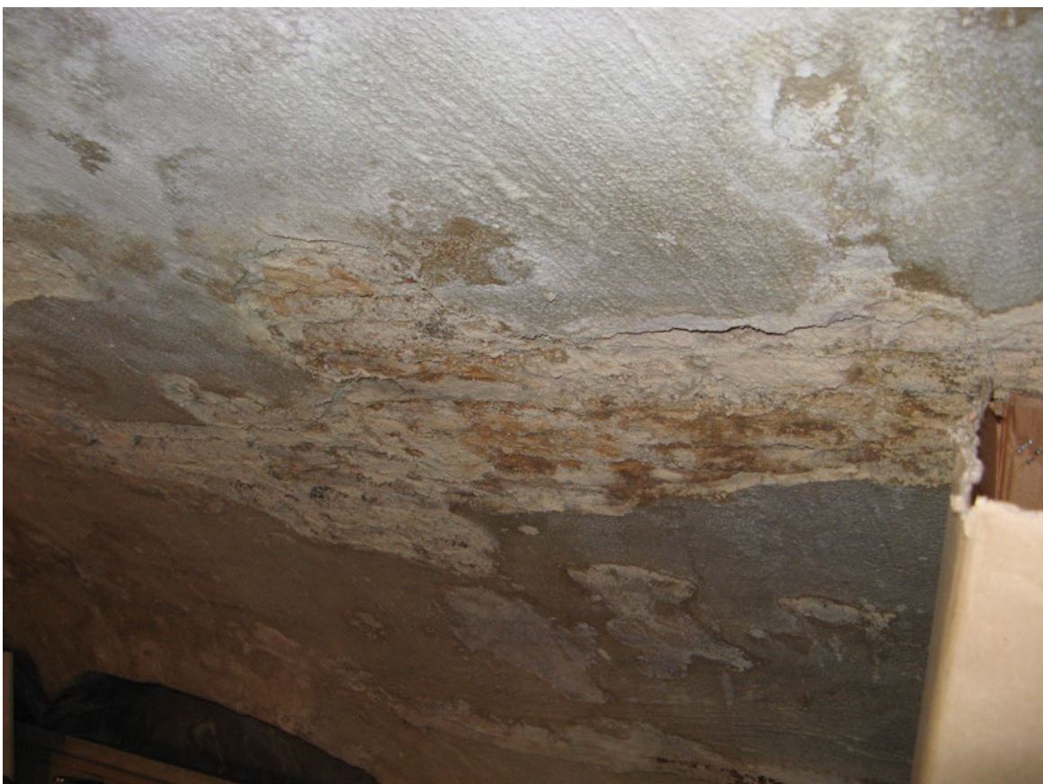
Foto 5: Betonconstructie gewelf/wand binnen 1 m., zichtbare wapening
