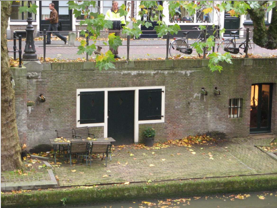
Foto 1: Aanzicht werfkelder buitenzijde
