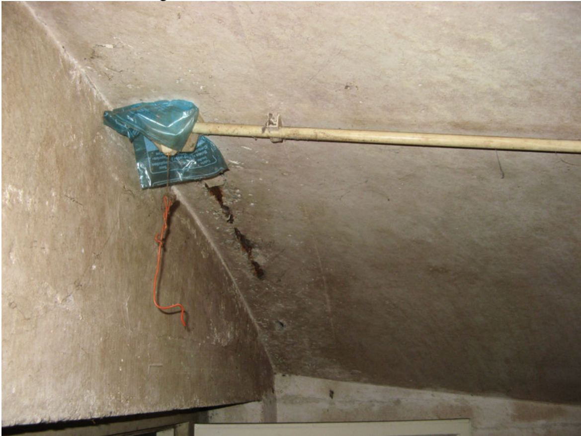
Foto 5: Betonconstructie gewelf/wand binnen 1 m., zichtbare wapening
