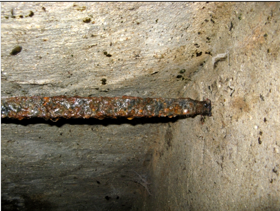
Foto 5: Muurankers gecorrodeerd.
