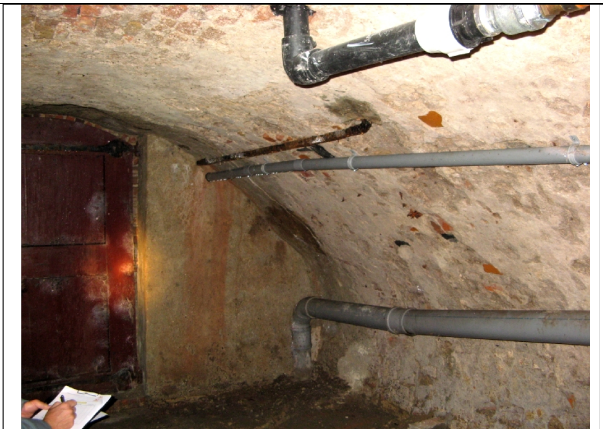
Foto 3: Aanzicht binnenzijde werfmuur.
