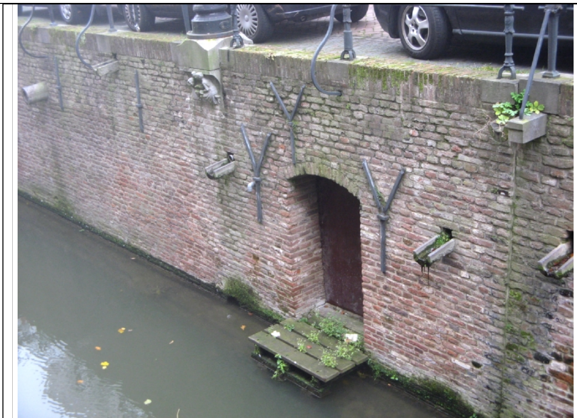
Foto 1: Aanzicht werfkelder buitenzijde
